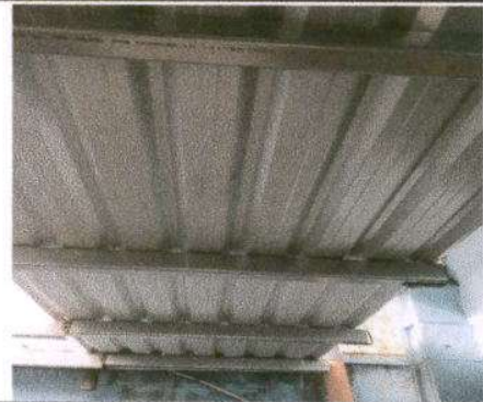
Foto 2: Sustitución de estructura de soporte de metal por metal en baños
