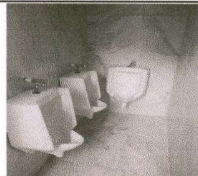
Foto 6: Sustitución de inodoro por mingitorio a baño 1.
