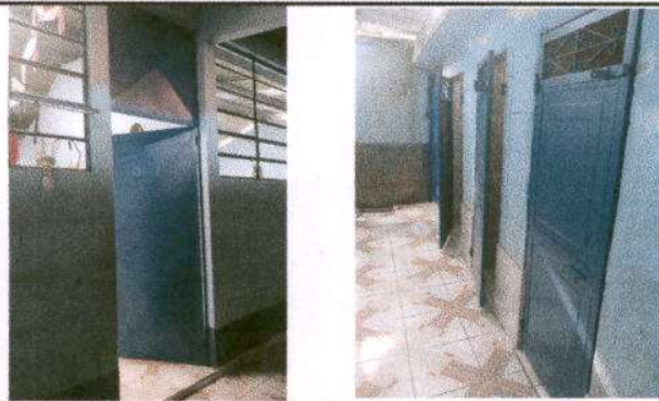
Foto 3: Mantenimiento a estructura (lijado, cambio de tubo, cepillado, aplicación de pintura) a puertas del módulo 1, 2, 3, y de 4 baños.
