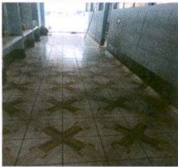
Foto 5: Sustitución de piso de torta de concreto por piso cerámico en corredor frente a módulo 1, 2, 3.
