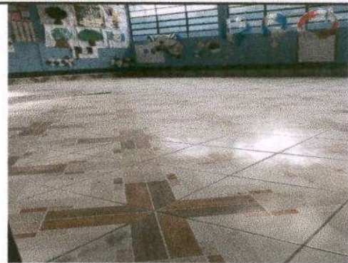
Foto 4: Sustitución de piso de cemento líquido por cerámico en módulo 1, 2, 3.
